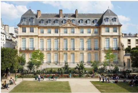
Façade of the Hôtel Salé
