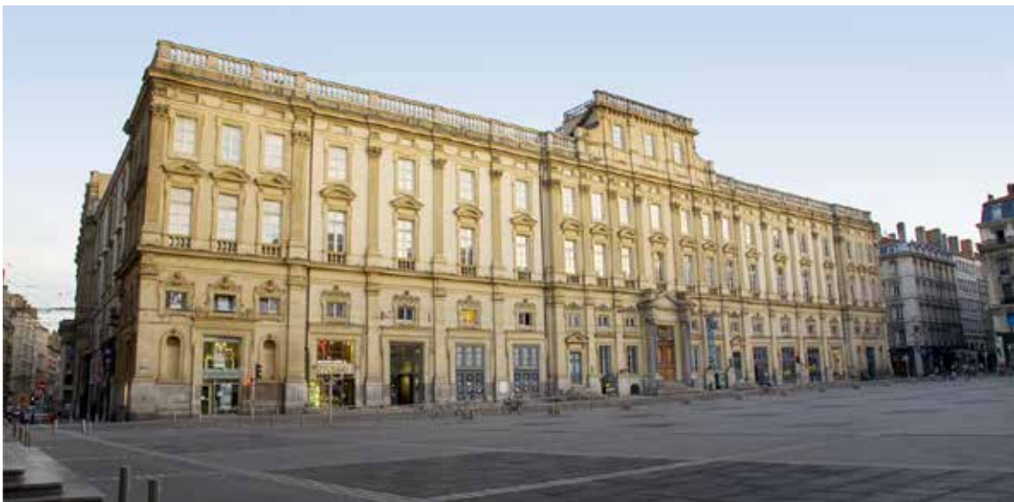
Facade du musée des Beaux-Arts de Lyon. Image © Lyon MBA - Photo Corentin Mossière
