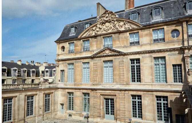
Façade sur cour de l'hôtel Salé
